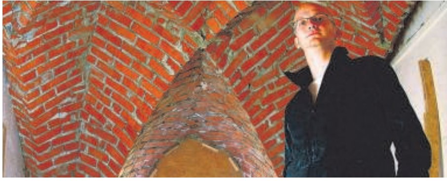
Das Ergebnis der Diplomarbeit von Chris Tauchnitz ist nicht auf Papier gedruckt. Er hat es selbst aus Mörtel und Stein gemauert. Foto: Sebastian Fischer
